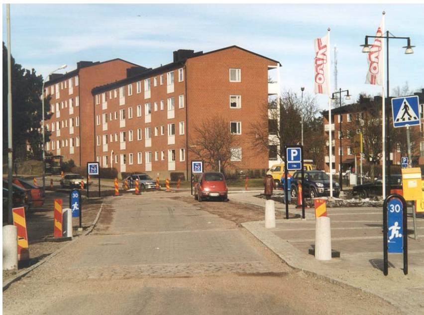
Figur 5. Gångpassagen över Hjortmossegatan vid VIVO efter ombyggnaden (korsning 2).
