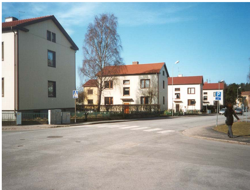
Figur 2 Hörngatan/Klintvägen före ombyggnaden (korsning 1).
