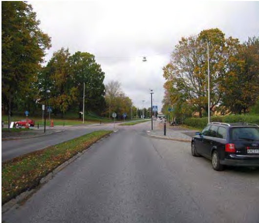
Figur 1 Övergångsställe N1, Albrektskatan/Klingsbergsgatan, Norrköping. Insnävat och intensivbelyst med en armatur samt utrustat med pollare.
