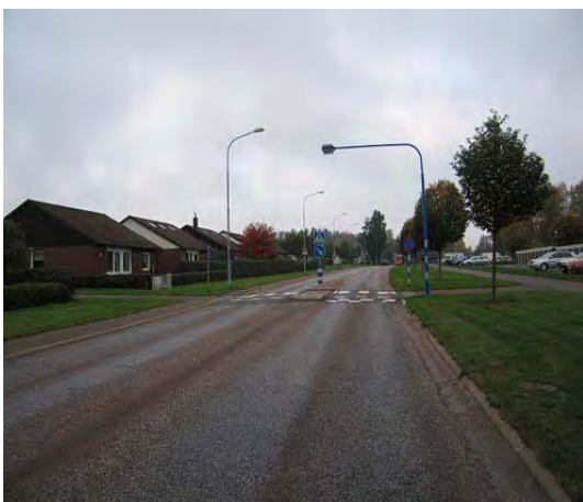
Figur 5 Övergångsställe M1, Gustavsviksvägen, Motala. Asymmetrisk intensivbelysning.
