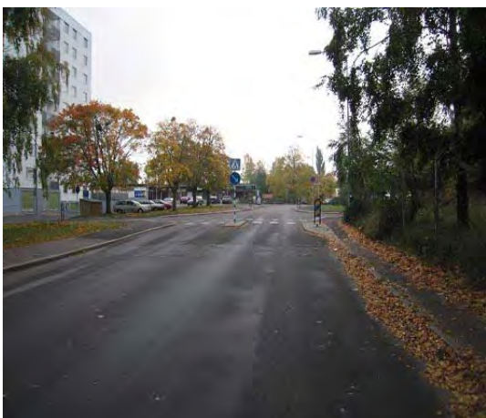
Figur 8 Övergångsställe M4, Ulaxgatan, Motala. Något insnävat med pollare.
