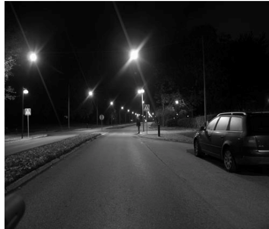
Figur 1 Övergångsställe N1, Albrektskatan/Klingsbergsgatan, Norrköping. Insnävat och intensivbelyst med en armatur samt utrustat med pollare.
